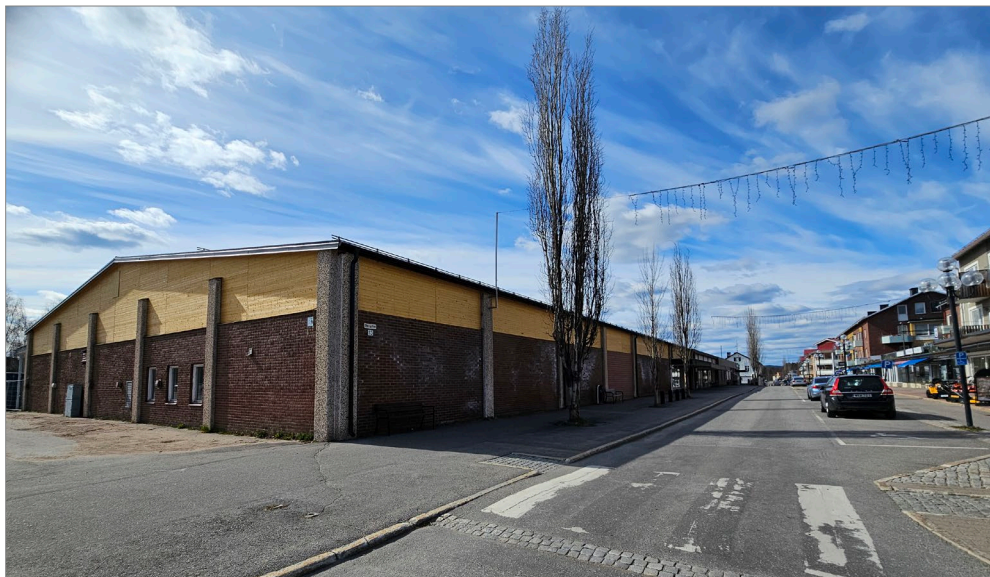
Fotografi av befintlig byggnad inom planområdet, maj 2025.
